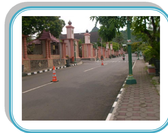
Jalan beraspal dan Jalan berpaving block
