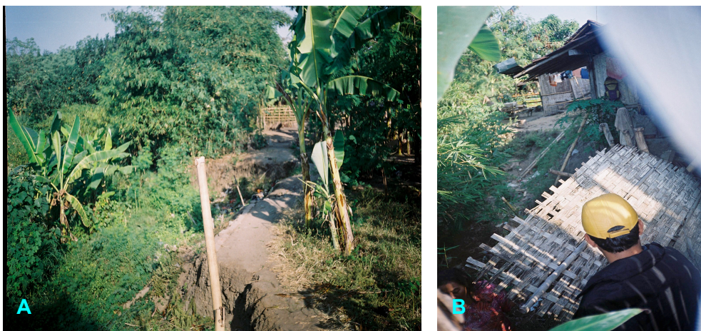
Gambar 1.2 Jalan Desa yang Longsor (A), Rumah Penduduk yang Hampir Roboh (B) di Dukuh turi Kab.Tegal.
