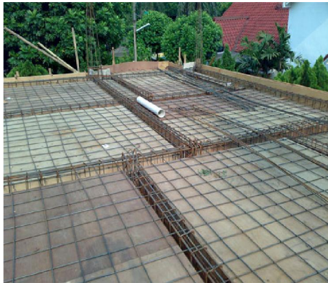
Gambar pekerjaan plat lantai.
