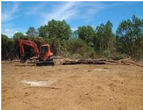
(Gambar 01.) Landclearing pada lokasi yang akan dibuat menjadi perumahan.
