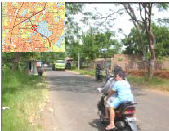
Gambar 4.32. Jalan Lokal di Lokasi Tirtoagung sebelum pembangunan jalan tol (Sumber: PT. Trans Marga Jateng, 2009)
