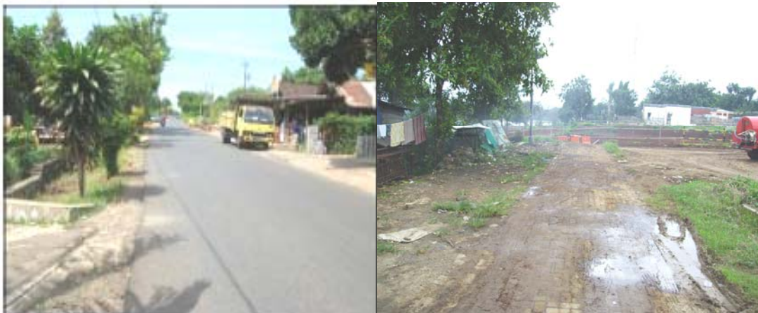
Gambar 4.33. Jalan Lokal di Lokasi Mulawarman sebelum pembangunan jalan tol (Sumber: PT. Trans Marga Jateng, 2009)
