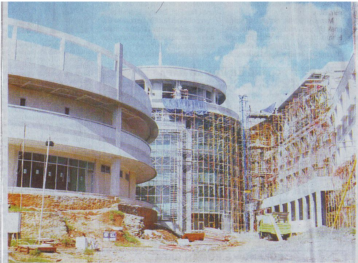
PROSES PEMBANGUNAN: Salah satu gedung rumah sakit milik Undip di Kampus Tembalang, kini dalam proses pembangunan. (37)
