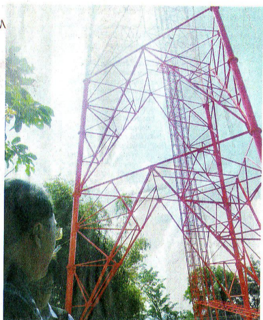
TOWER TELEKOMUNIKASI: Pembangunan tower telekomunikasi setinggi 150 meter di areal Gedung Widya Puraya Kompleks Undip Tembalang terus dilakukan. (37)
