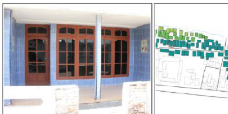
dinding tembok dikeramik pada lahan HM di daerah sempadan pantai
