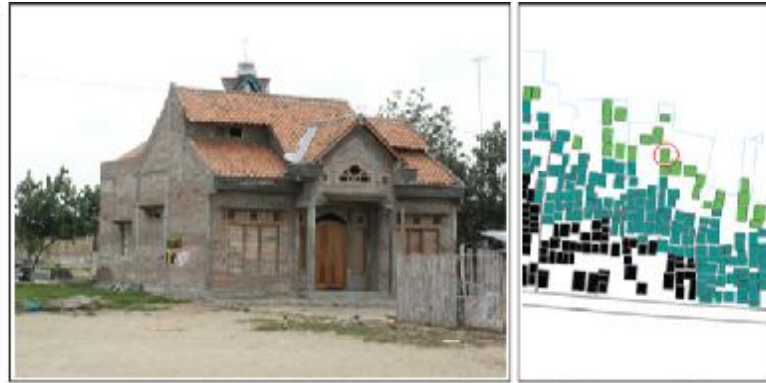
struktur rangka beton rigid status HGB di lahan reklamasi
