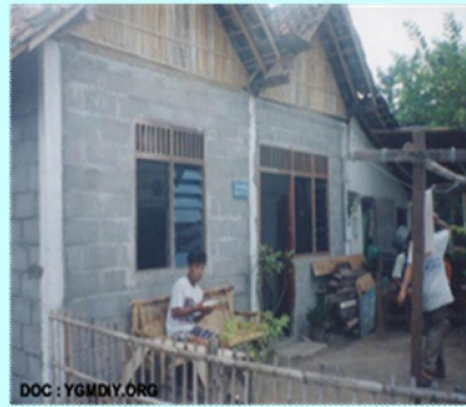
Sesudah diperbaiki, dinding dengan batako
