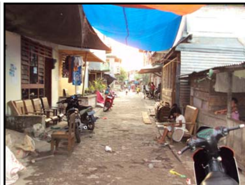
Tampak rumah masyarakat saling berhimpit dan akses jalan yang ada sempit. Sangat berbahaya jika sewaktu-waktu terjadi kebakaran.
