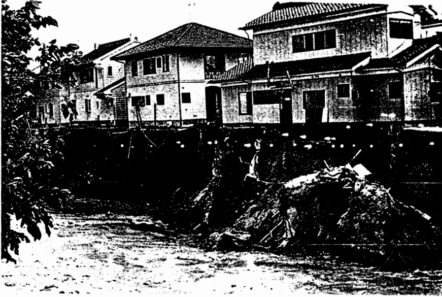
Gambar 7 a : Kerusakan lereng sungai akibat banjir 21)
