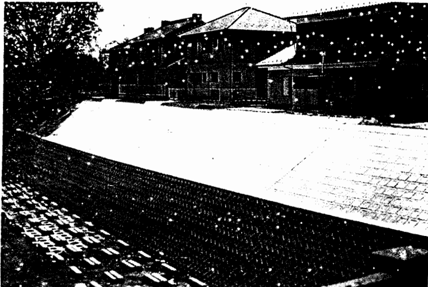
Gambar 7 b : Kerusakan lereng sungai akibat banjir sesudah diperbaiki 21)
