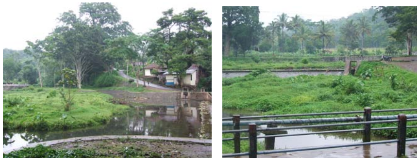
Delta yang ditumbuhi semak di embung dan sungai Senjoyo akibat sedimentasi Sumber: Hasil observasi, 2007
