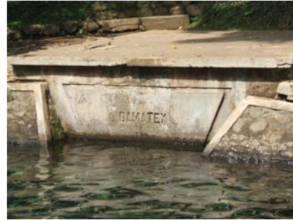
Bak Penampung sumber air PT Damatex
