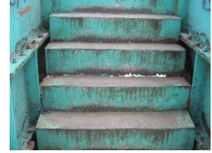
Gb 4.2 Konstruksi besi pada lantai
