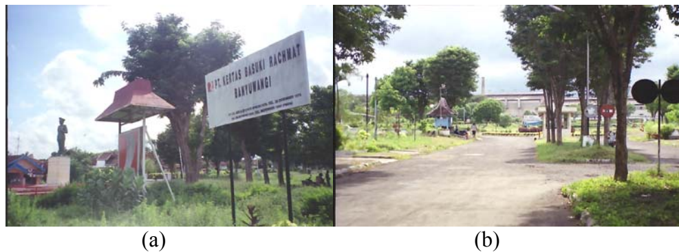
Gambar 4. Foto PT Kertas Basuki Rachmat : (a) Bagian depan (pintu masuk) (b) Bangunan pabrik PT Kertas Basuki Rachmat
