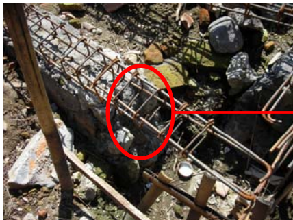
Angkur dikaitkan pada tulangan sloof kemudian
