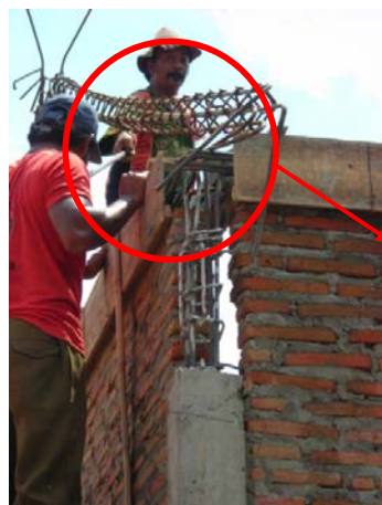
Ring Balk dan kolom, tulangan saling dikaitkan dan sebagian kolom dicor bersamaan dengan balok.
