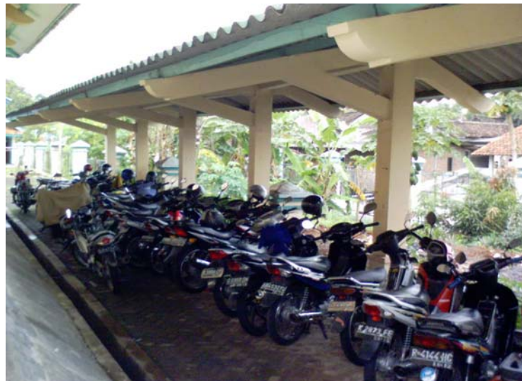
Shelter Sepeda Motor
