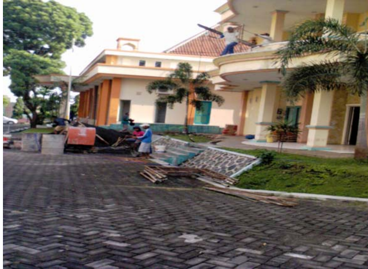
Foto Gedung D Asrama Peserta Diklatpim IV
