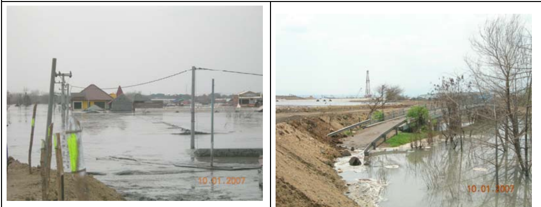
Kerusakan infrastruktur karena luapan air Lumpur yang tidak pernah berhenti
