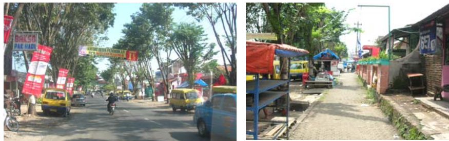
Foto 4.5 Kondisi jalan dan trotoar
