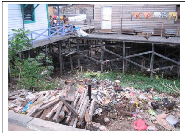
GAMBAR 3.20 KONDISI PERMUKIMAN YANG MASIH TERLIHAT KUMUH DENGAN ADANYA SAMPAH-SAMPAH YANG DIBUANG SEMBARANGAN (Sumber : Hasil Penelitian , 2004)
