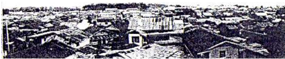
GAMBAR 3.2 KONDISI PERMUKIMAN EX-KEBAKARAN FLAMBOYAN BAWAH SEBELUM KEBAKARAN
