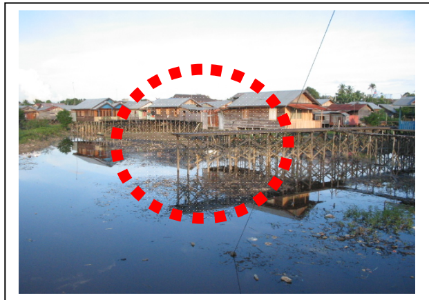
GAMBAR 4.3 FASILITAS INFRASTRUKTUR JALAN TITIAN LINGKUNGAN 2M YANG MASIH BELUM SELESAI (Sumber : Hasil Penelitian, 2004)
