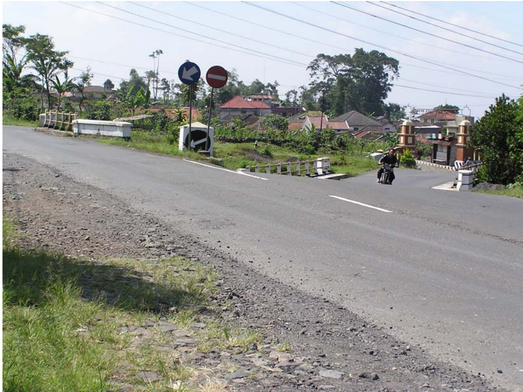
Gambar 5.37. Jembatan dan jalan raya Temanggung-Wonosobo
