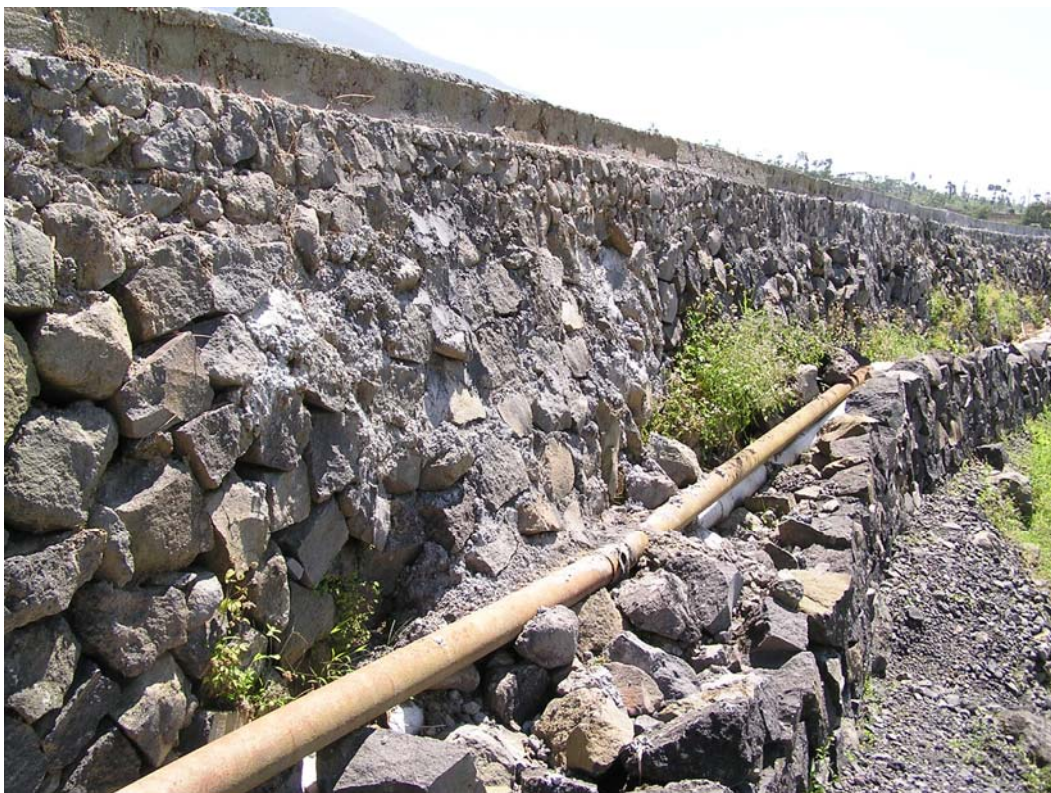
Gambar 5.36. Saluran irigasi di bagian atas lokasi penambangan
