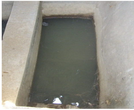
Gambar 22. Air Hasil Proses IPAL pada Bak Aerasi
