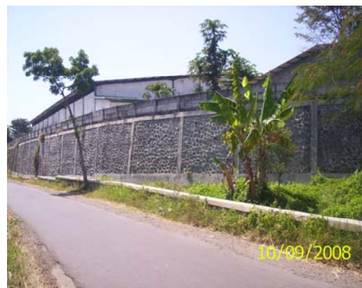
GAMBAR 4.3 KONSTRUKSI TALUD PENAHAN TIMBUNAN TANAH PT. APAC IINTI CORPORA
