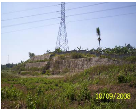
GAMBAR 4.2 KONSTRUKSI TALUD PENAHAN TANAH EBING PADA PT. MEDICO
