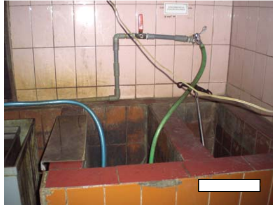
Gambar 4.6. Kondisi Kamar gelap (Bagian Basah)
