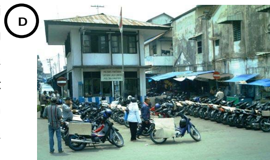
Foto 2.16 sisi ujung parit yang tertutup hingga badan jalan Sumber: Pengamatan lapangan, november 2006
