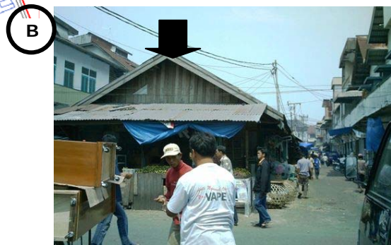
Foto 2.14 kondisi penutupan parit oleh bangunan Sumber: Pengamatan lapangan, november 2006
