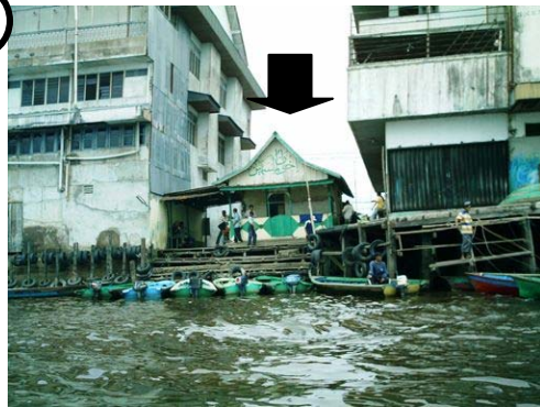
Foto 2.21 akses parit yang tertutup oleh bangunan ibadah Sumber: Pengamatan lapangan, november 2006
