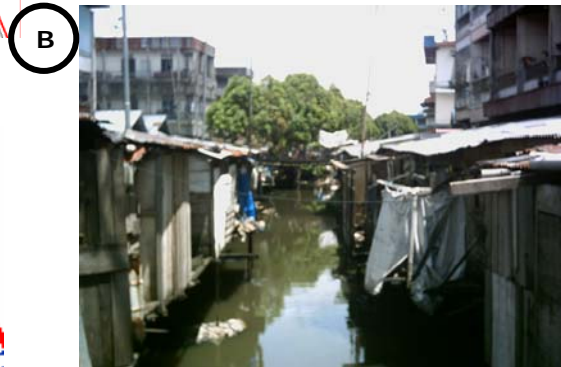
Foto 2.18 kondisi parit yang mengalami penyempitan Sumber: Pengamatan lapangan, november 2006
