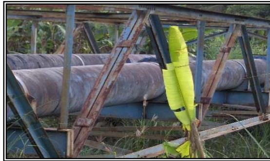
Pembangunan fasilitas pipa di Kudu memperlancar pasokan air bersih
