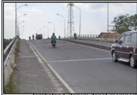
Jembatan Citarum dapat memperlebar arus lalu lintas
