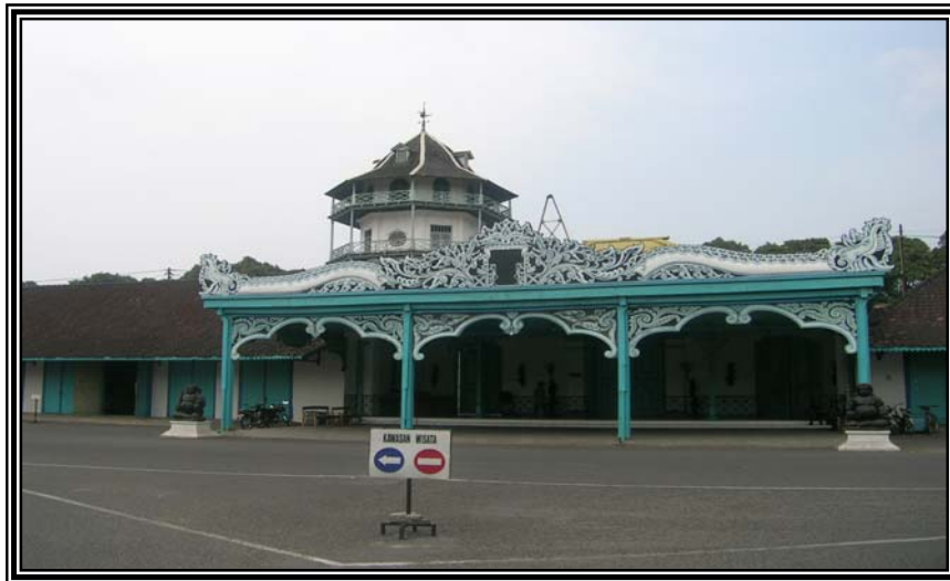
GAMBAR 3.3. KAMANDUNGAN DENGAN LATAR BELAKANG SONGGO BUWONO (Sumber: Dokumentasi Peneliti, 2005)
