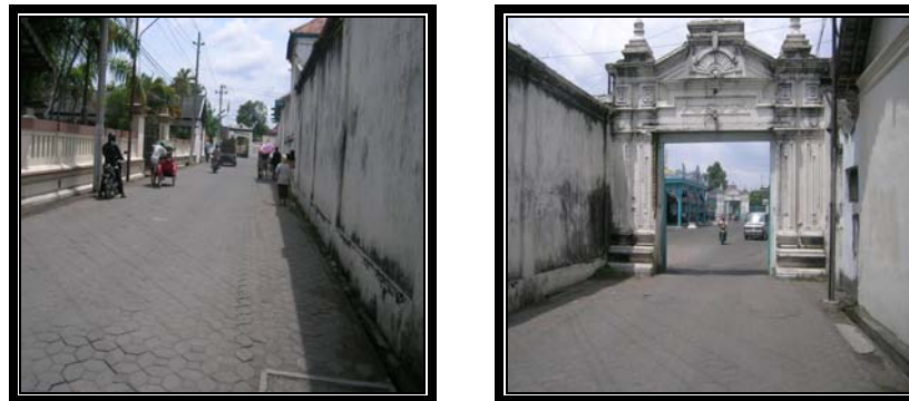
GAMBAR 4.21. JALAN MENUJU KE MUSEUM, TIDAK ADA CANOPY DAN TROTOAR Sumber: Dokumentasi Peneliti, 2005
