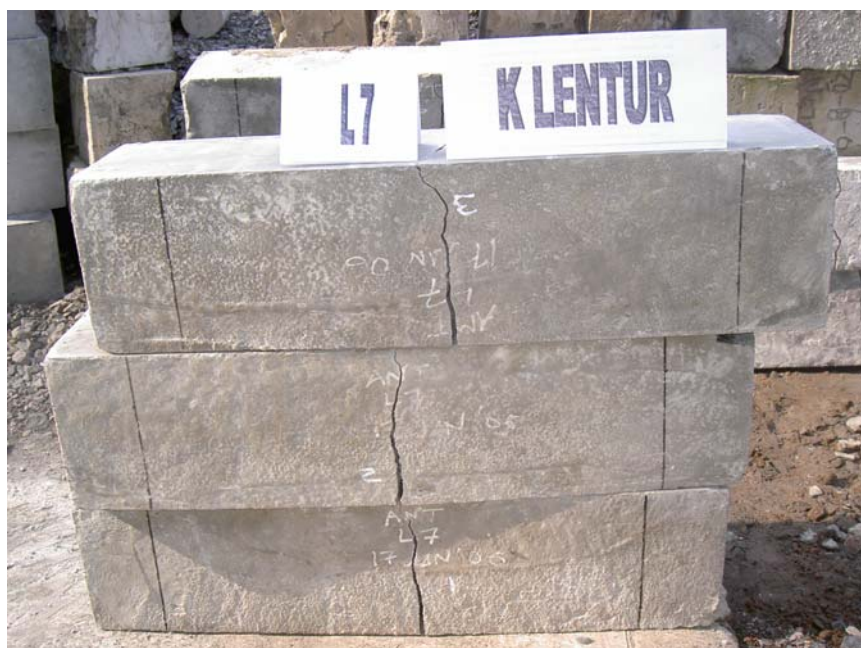
Gambar Tampang Retak pada Balok Beton Serat dengan \varnothing 1,2 mm dan panjang 72 mm
