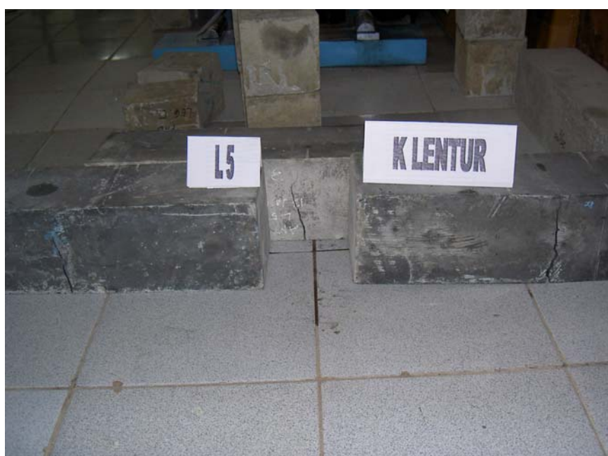
Gambar Tampang Retak pada Balok Beton Serat dengan \varnothing 0,9 mm dan panjang 67,5 mm
