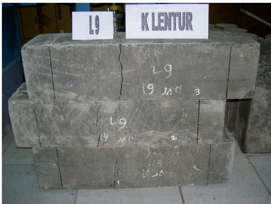
Gambar Tampang Retak pada Balok Beton Serat dengan \varnothing 1,2 mm dan panjang 108 mm
