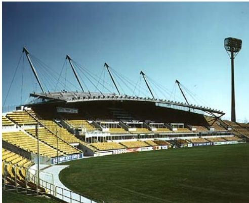
Rangka atap baja ditarik oleh kabel-kabel yang dikaitkan pada tiang penggantung
