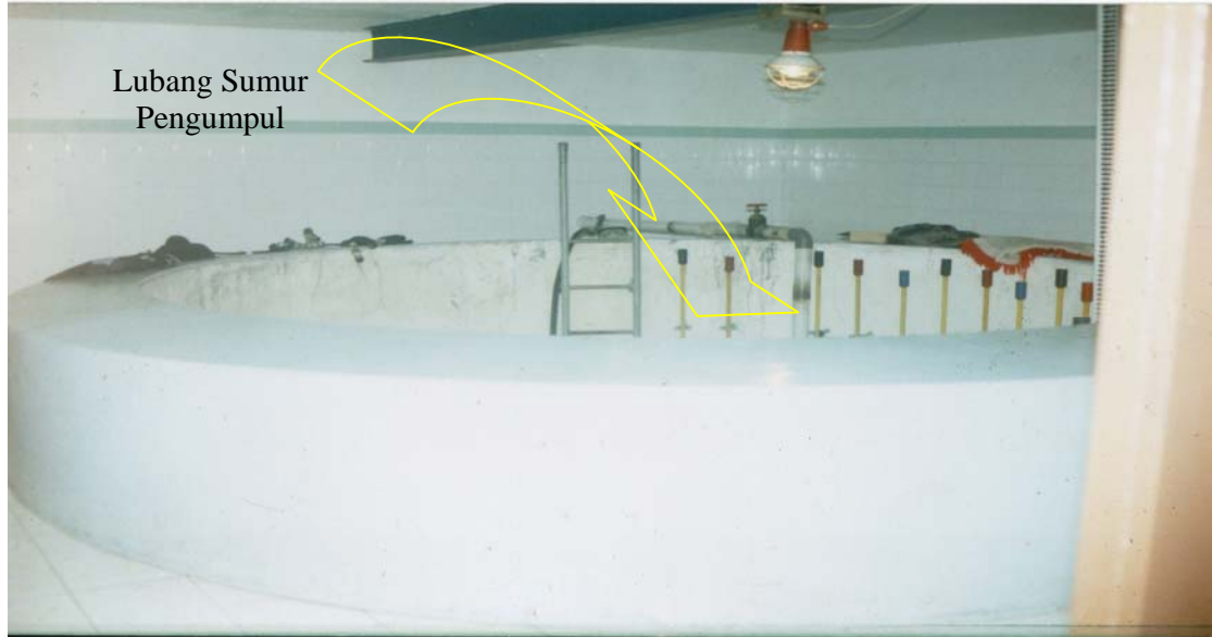
Gambar 3.6. Sumur Pengumpul yang dibangun tahun 1982
