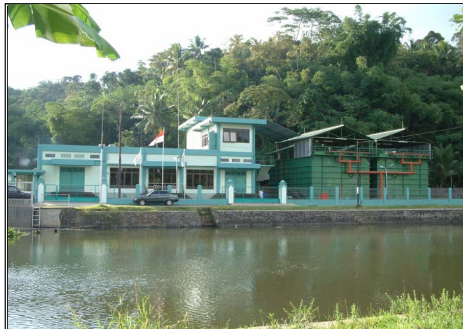
GAMBAR 3.2 INSTALASI PENGOLAH AIR PT.STU
