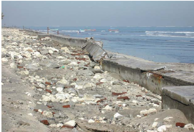
Gambar 4.4. Konstruksi Seawall Hotel Kartika Plaza hancur diterjang ombak (Sumber : Pratista, diambil tahun 2003)
