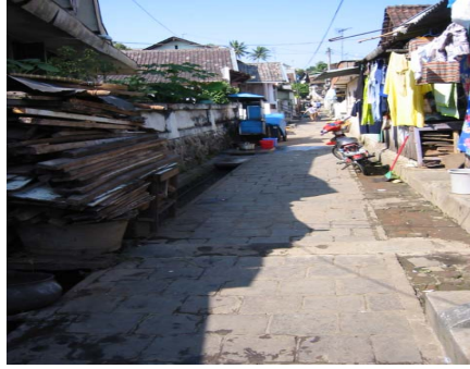
GAMBAR 3.8 KONDISI JALAN LINGKUNGAN DI KAWASAN PANCURAN DI KAWASAN PANCURAN
