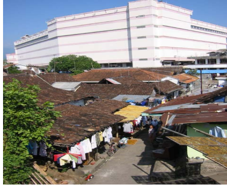
Gambaran kepadatan bangunan di kawasan Pancuran yang terletak di pusat kota yang merupakan permukiman yang terpadat dan berkesan kumuh
