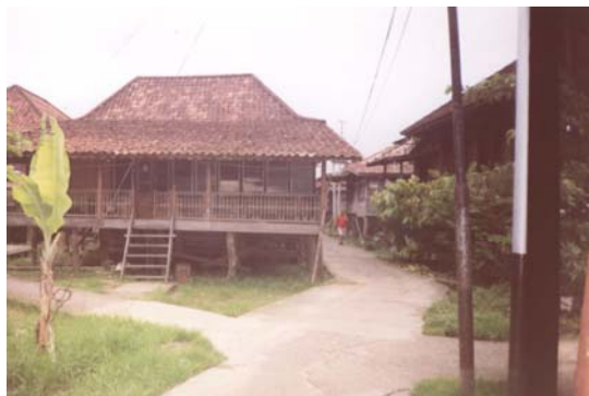
Gambar 2 : Kondisi Jalan Lingkungan (Sumber Dokumentasi Pribadi)
