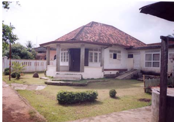
(Gambar 5, Bentuk Bangunan Modern)
