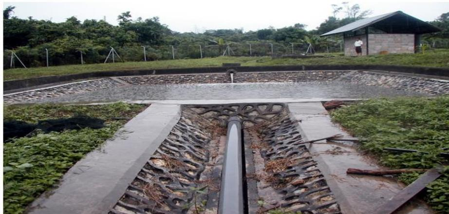
**Gambar 11. Kolam Efluen dan Pipa *Overflow* ke Badan Air**
