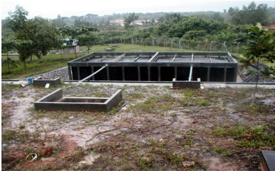
**Gambar 6. Bak Influen dan Bioreaktor/Aerator**
