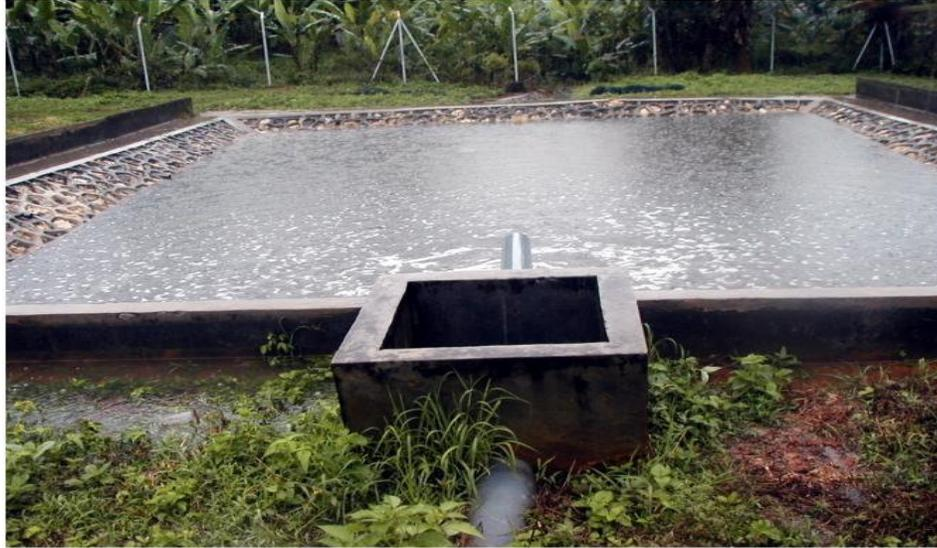
**Gambar 10. Bak Efluen/Kolam Stabilisasi Sebelum Dibuang ke Badan Air**
