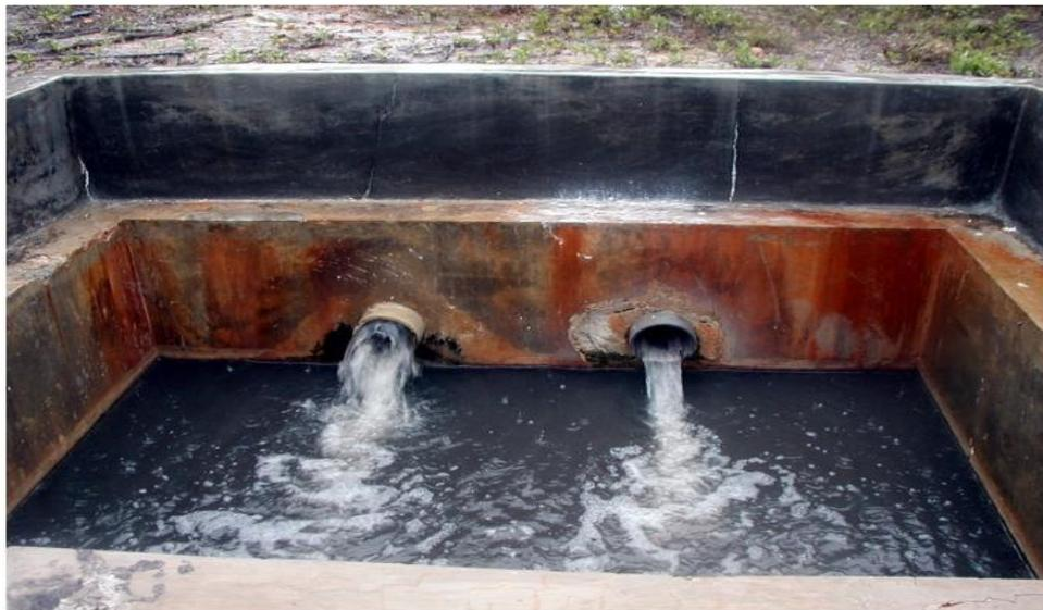
**Gambar 5. Kolam Influen. Pipa di kiri efluen dari septik tank unit 1 dan pipa di kanan efluen dari septik tank unit 2 dan 3**
