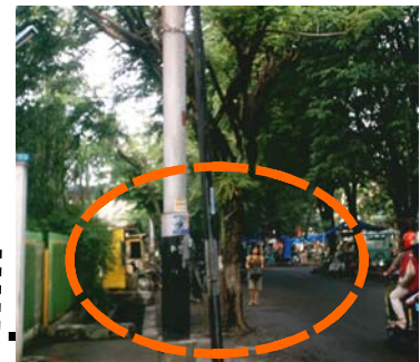
Foto 10. Tiang listrik dan lampu jalan yg terletak pada bahu jalan
