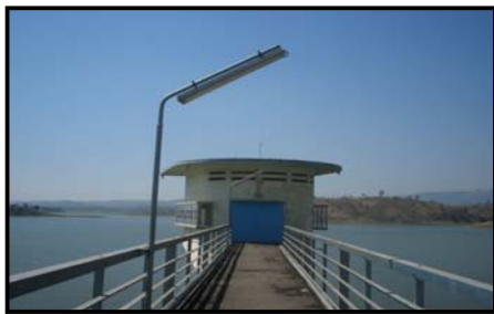
Menara intake (Pengatur operasional waduk)
