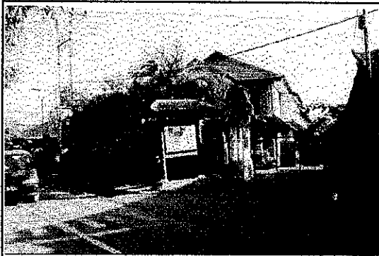
Pelanggaran rencana permukiman menjadi perdagangan dan jasa dari bangunan Garmen di desa Pemogan Kec. Denpasar Selatan
