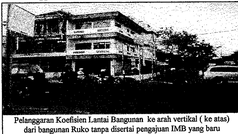
Gambar 3.15 Pelanggaran Rencana Koefisien Lantai Bangunan
