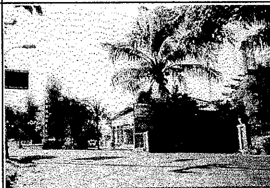
Pelanggaran rencana permukiman menjadi perdagangan dan jasa dari toko accessoris dan bengkel di jalan Bung Tomo Kec. Denpasar Barat
