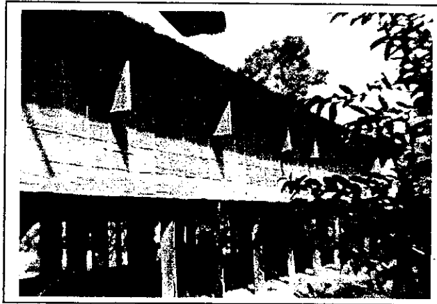
Gambar : 5.34 a. Konstruksi Dinding Betang Toyoi. Sumber : hasil pengamatan, Pebruari 2004.
