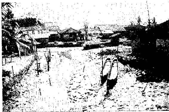
Tempat bersandar perahu yang ada dibelakang pekarangan rumah yang berada dekat dengan perairan dengan kondisi cukup parah
