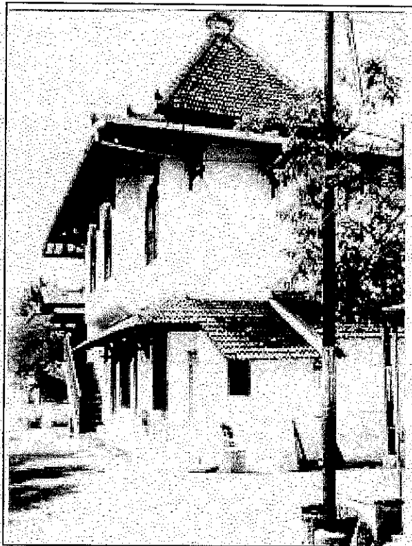
Gambar III. 11 : FOTO FASILITAS SOSIAL DI BALUWARTI
