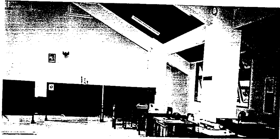
Gambar F.5.10 Ruang kerja Bagian Lingkungan Hidup, penataan furniture yang menghadap sumber cahaya yang besar dari bidang skylight menimbulkan silau
