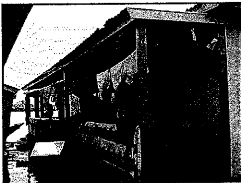
Gambar 4.17. Overstek rumah Rakit Bpk. Muni (Sumber : Data Lapangan)
