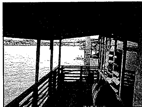
Gambar 4.18. Overstek rumah Rakit Bpk. Rustam (Sumber : Data Lapangan)
