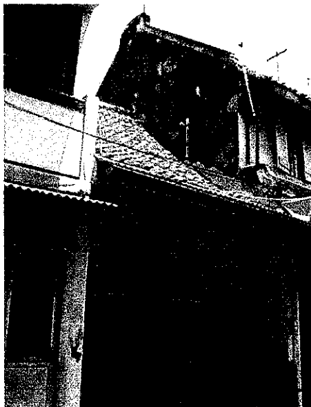
Bangunan rumah toko di Gang Pasar Baru dengan jendela kayu yang menyatu dengan pintu
