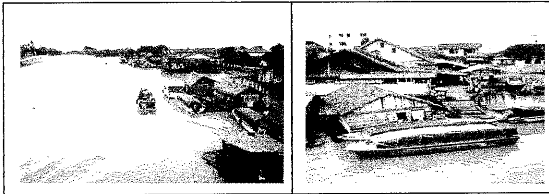
GAMBAR IV.7 KONDISI RUMAH LAMTING DI KAWASAN GEDANG.
