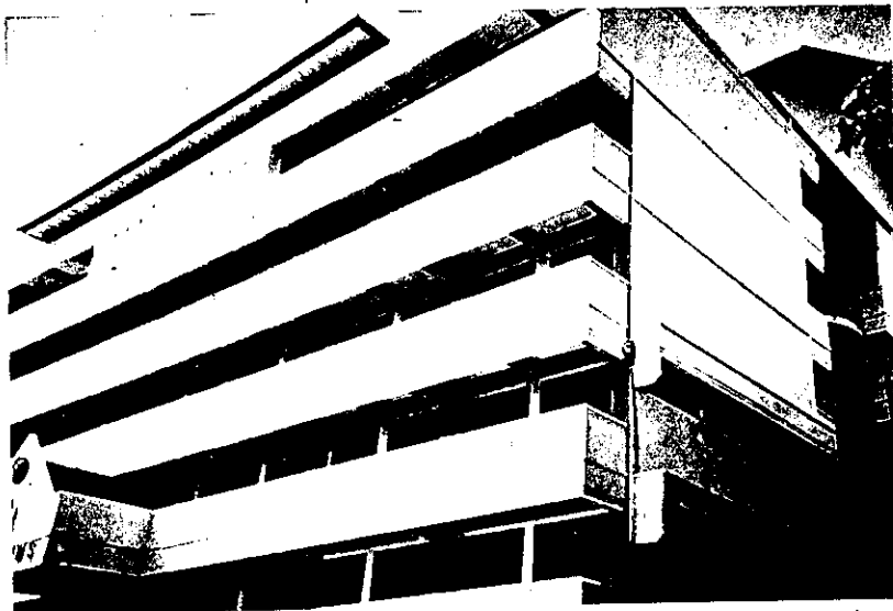
Foto 23 . Fasade Timur laut Bangunan ( sumber Observasi Lapangan ) Fasade Timur Laut yang sarat dengan elemen balkon dan kanopi
