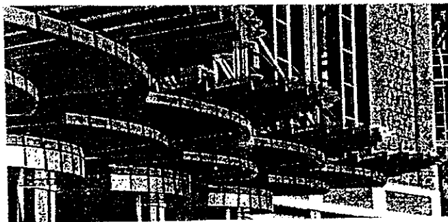
Gambar 10. Kanopi Pada Bangunan.
