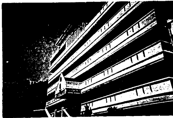
Foto 02 : Elemen Bangunan Balkon dan Kanopi sebelah Timur Laut sebagai Obyek Penelitian
