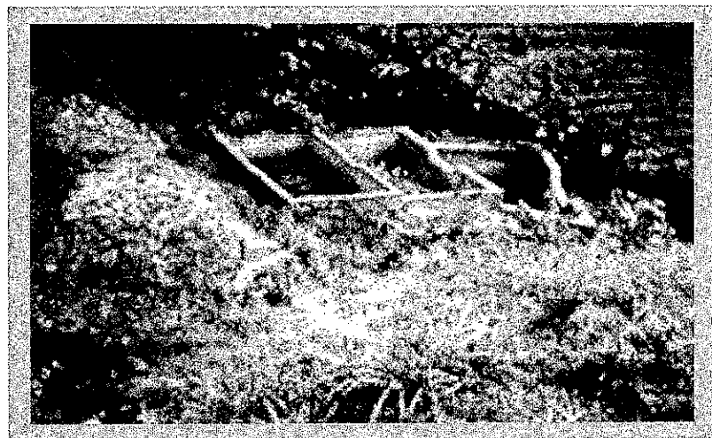
Gambar 4.8. Bak Penampung / Pengolah Lechate ( penghujan )
