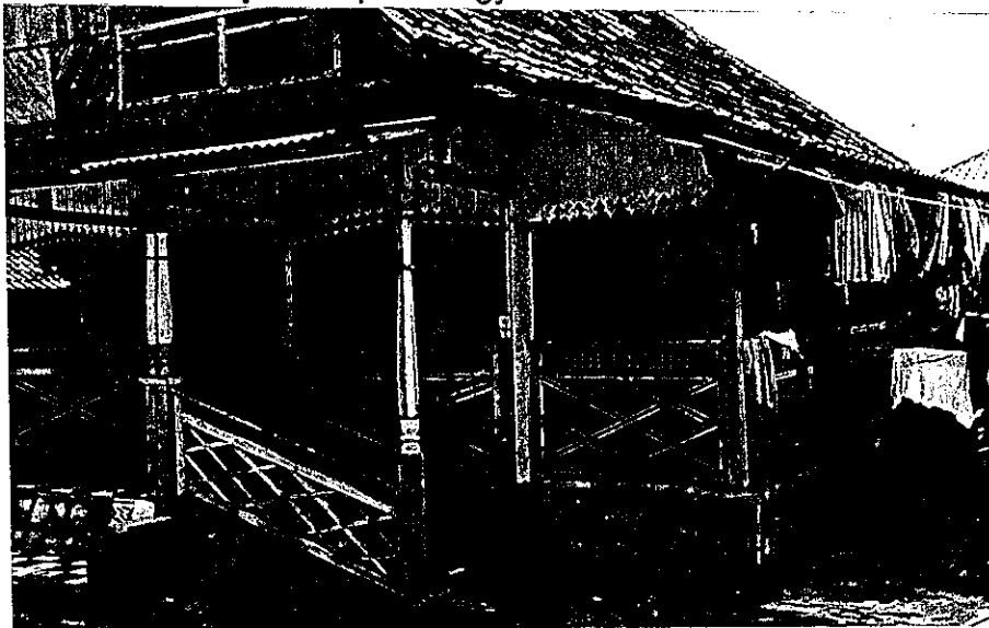
Gambar G.4.20. : lantai bangunan yang dipertinggi. (Sumber : hasil survei)
