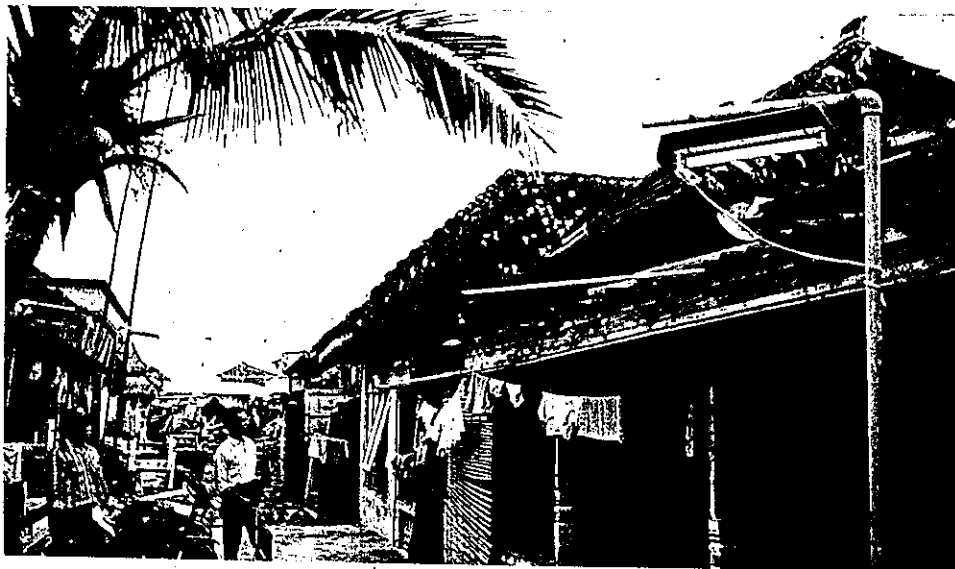
Gambar G.4.21. : Orientasi bukaan jendela yang menghadap kebarat (Rumah tipe 7), dengan penyelesaian khusus (dengan krei bambu penahan sinar dan pohon kelapa) (Sumber : survei April 2000)
