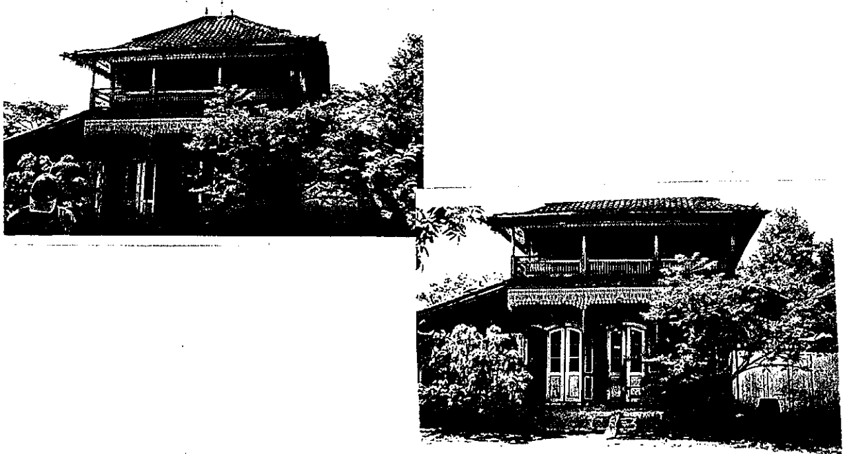
Gambar G.4.14. Rumah rakyat bertingkat di pedesaan Demak (Sangat jarang rumah tradisional Jawa bertingkat) Lambresering papan berornamen berfungsi se- bagai pematah sinar (Foto hasil survei Maret, 2000)
