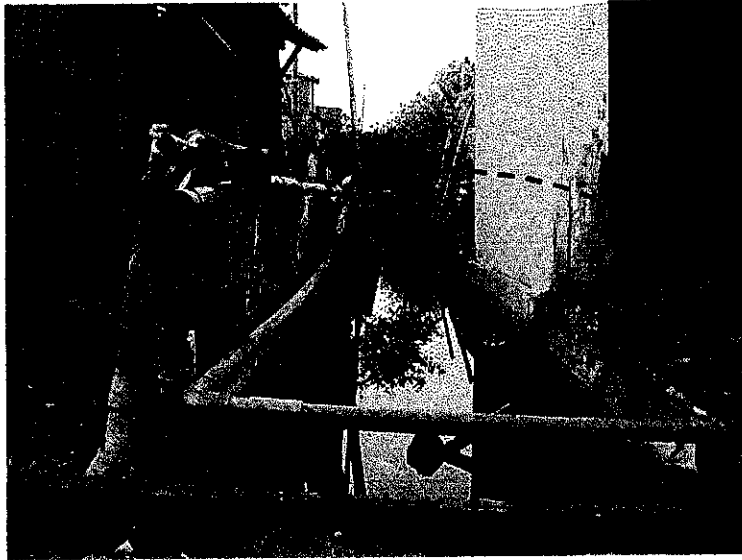
GAMBAR 3.9 KONDISI FASILITAS AIR BERSIH
