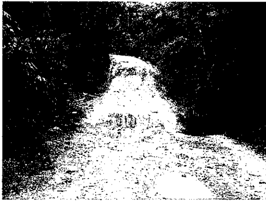
Kondisi ruas jalan Sungai Besar -- Perhentian Sungkai
