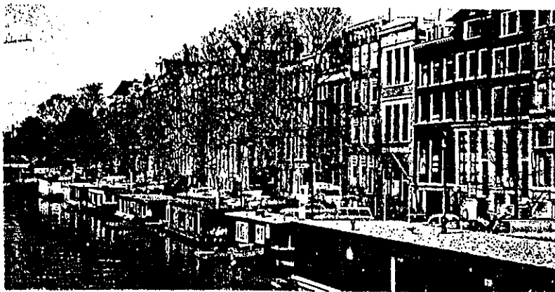
Gambar 3.10. Sebagian estefika fasade kawasan tepi air Amsterdam (Sumber : Holland In Close Up).
