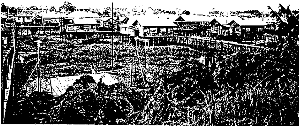
Gambar 2.3. Kawasan Tepi Sungai Kahayan Di Musim Kemarau. Kawasan terbangun terlihat berdiri diatas daratan (Sumber : Foto pribadi, September 2000).
