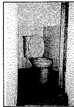
Gambar 4.28. Jenis WC yang memakai septic tank (dipakai pada rumah yang terletak di dekat area daratan) (Sumber : Survai, 2004)
